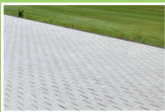
Frankenpflaster- Drain mit 8 mm Fuge
